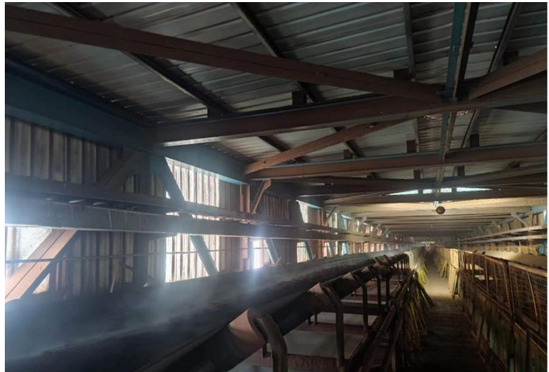
烧结前混合料 (二次混合) 位置现场图
